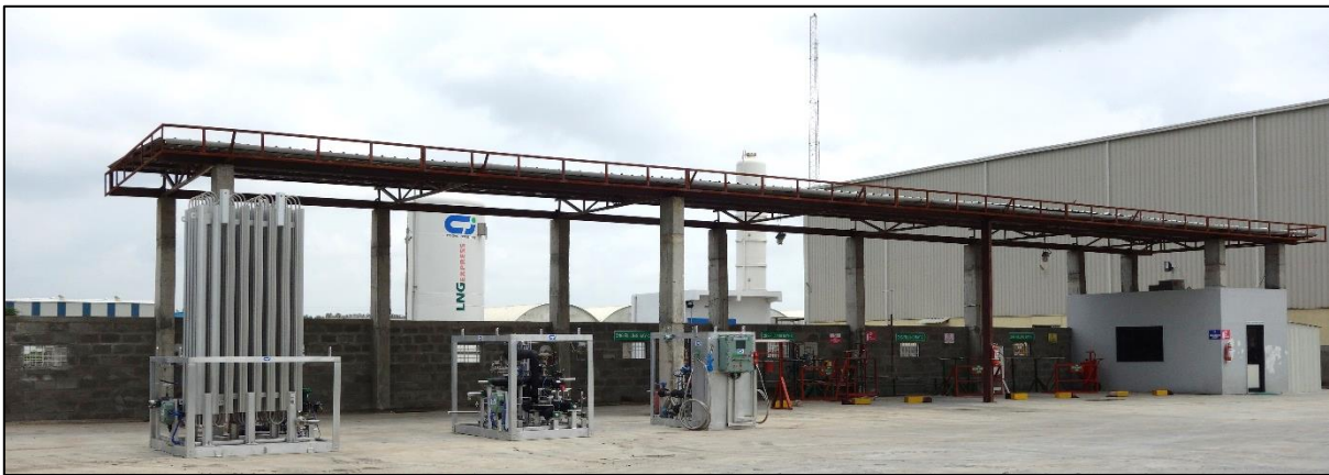
Courtesy : Cryogas equipment Pvt Ltd & LNG Express (India) Pvt Ltd
